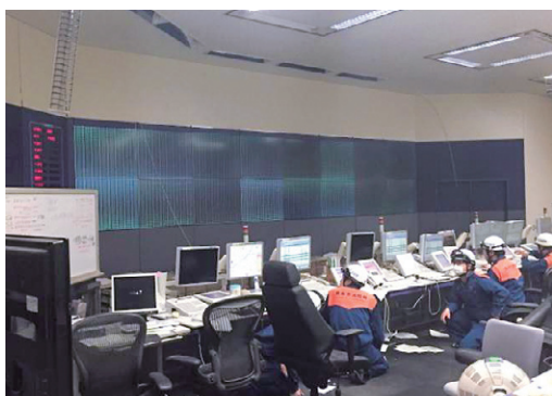
本震直後の指令管制室
